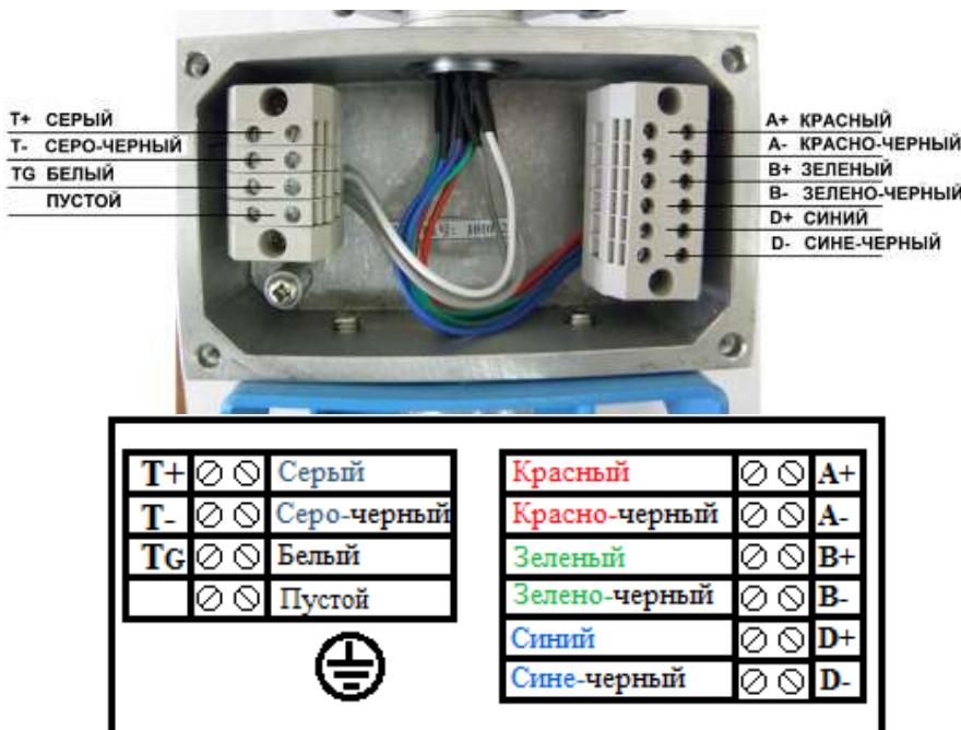
Рисунок 12 - Внешний вид распределительной коробки вычислителя
